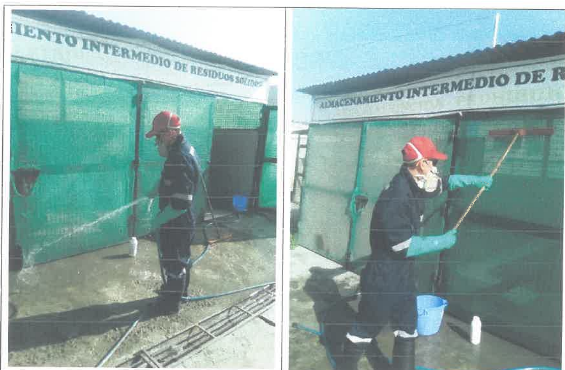
FOTOGRAFÍA N° 21. El personal encargado realiza los trabajos de limpieza y desinfección de las áreas de almacenamiento intermedio.
