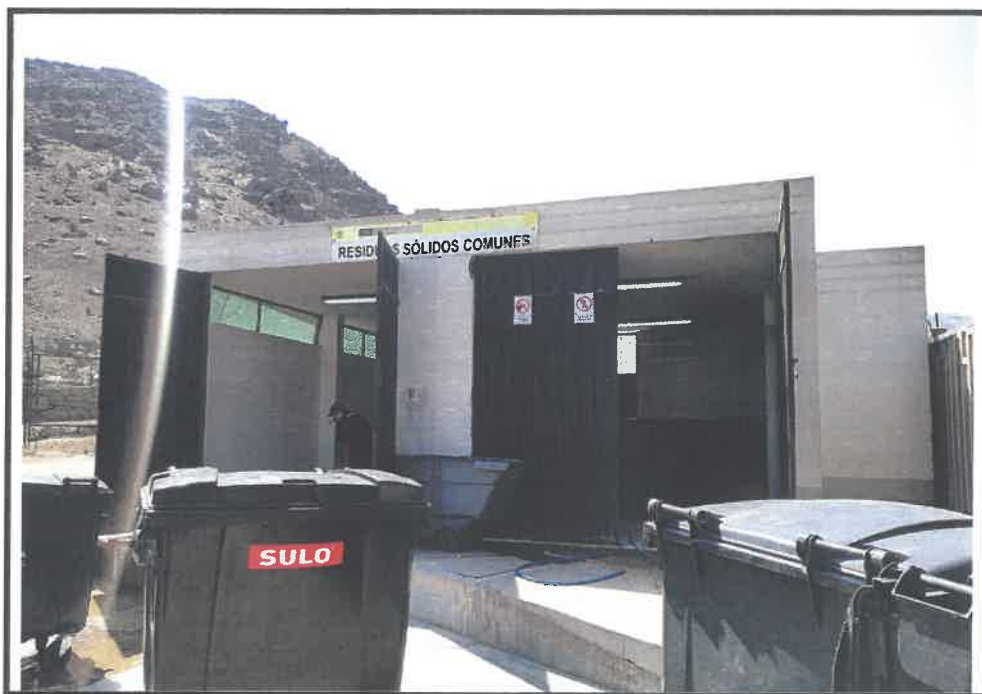
Fotografía N° 2. Almacenamiento Central para Residuos Comunes
