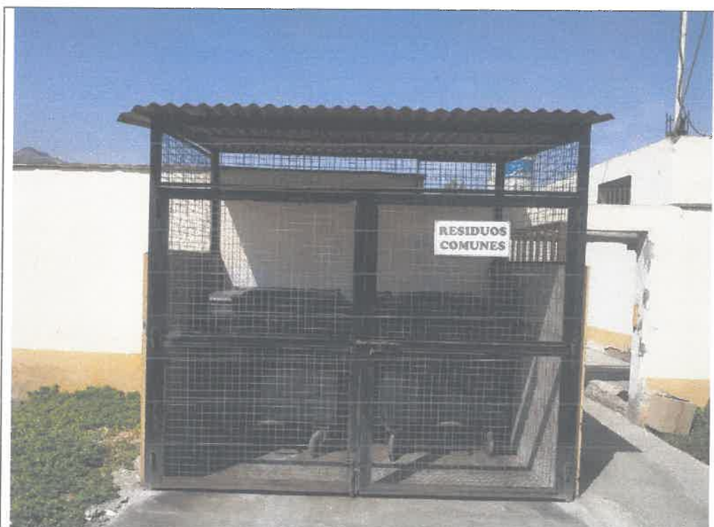
FOTOGRAFIA N° 10. Almacenamiento intermedio N°6 de residuos sólidos (comunes), cuenta con las medidas de seguridad.
