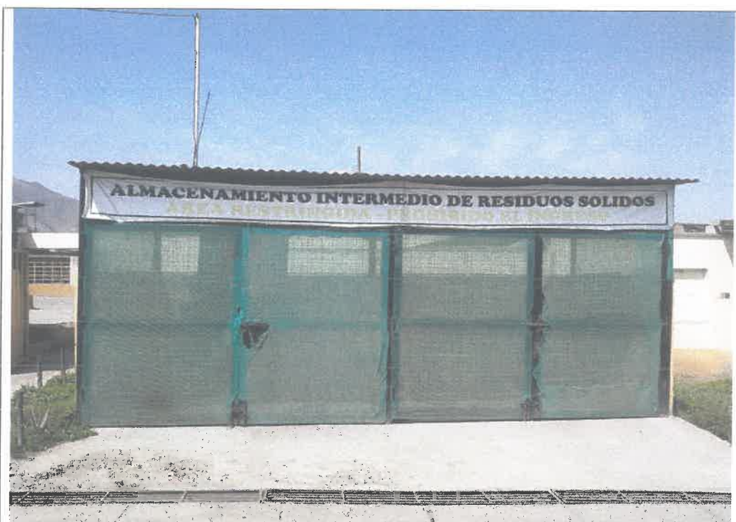
FOTOGRAFÍA N° 9. Almacenamiento intermedio N°5 de residuos sólidos (biocontaminados), cuenta con las medidas de seguridad e identificación.
