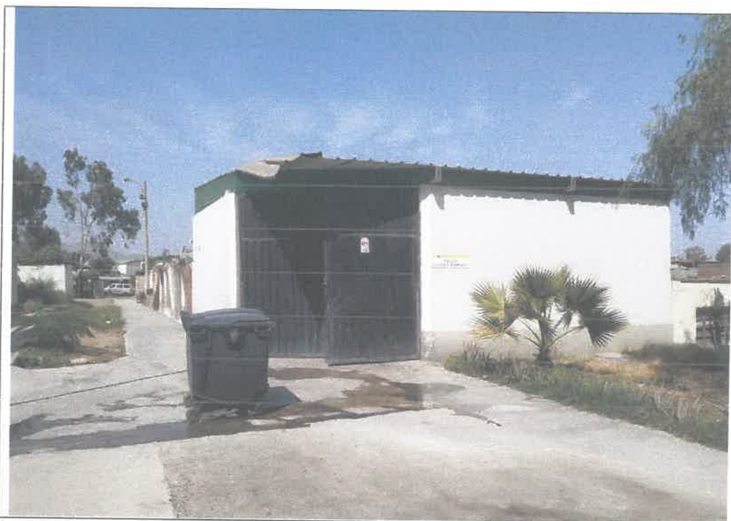
FOTOGRAFIA N° 17. Área de almacenamiento central o centro de acopio para residuos biocontaminados del HNSEB
