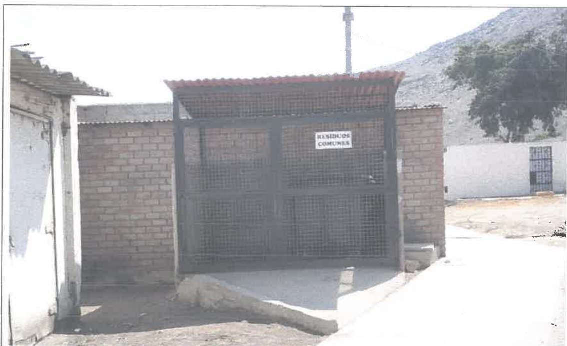
FOTOGRAFÍA N° 8. Almacenamiento intermedio N°4 de residuos sólidos (comunes), cuenta con las medidas de seguridad.
